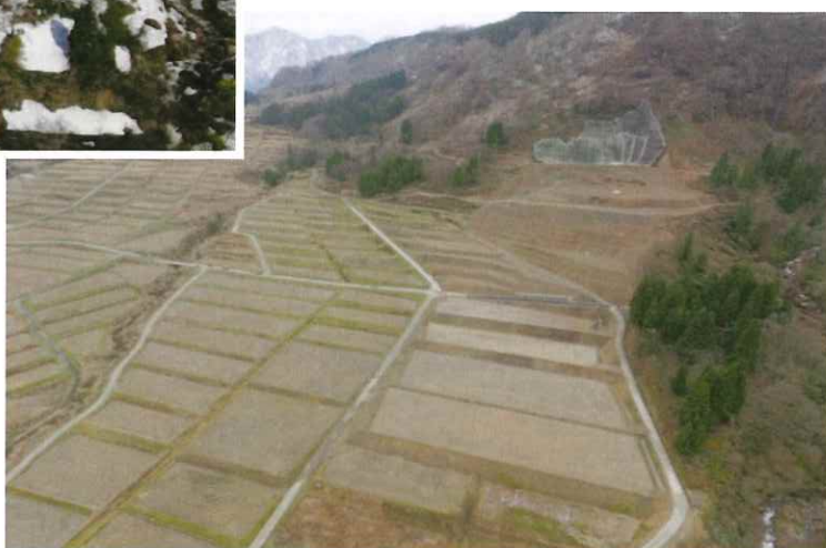
地すべり現場竣工 (H28年11月)
