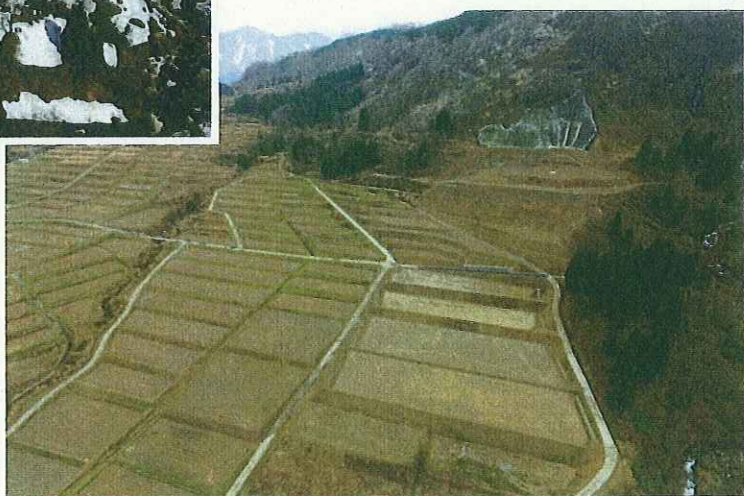
地すべり現場竣工 (H28年11月)
