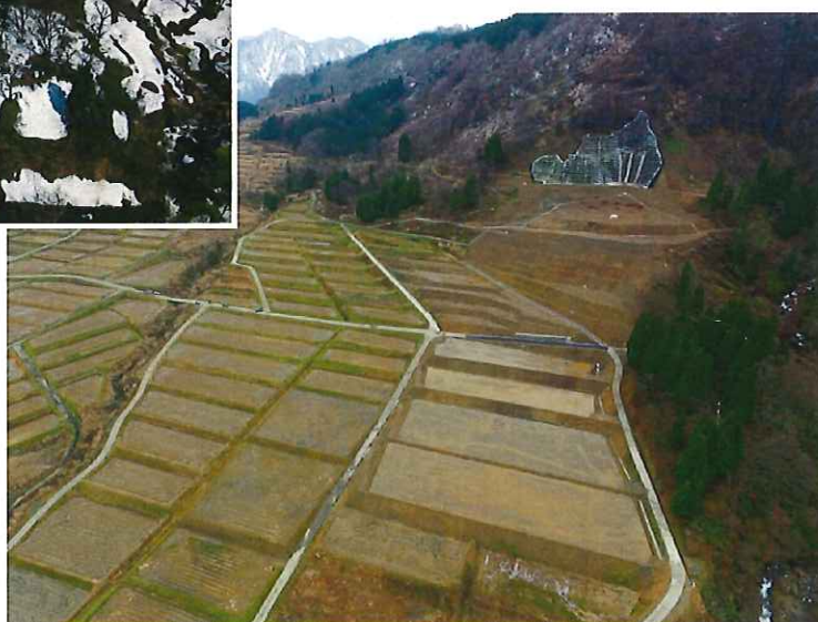
地すべり現場竣工 (H28年11月)
