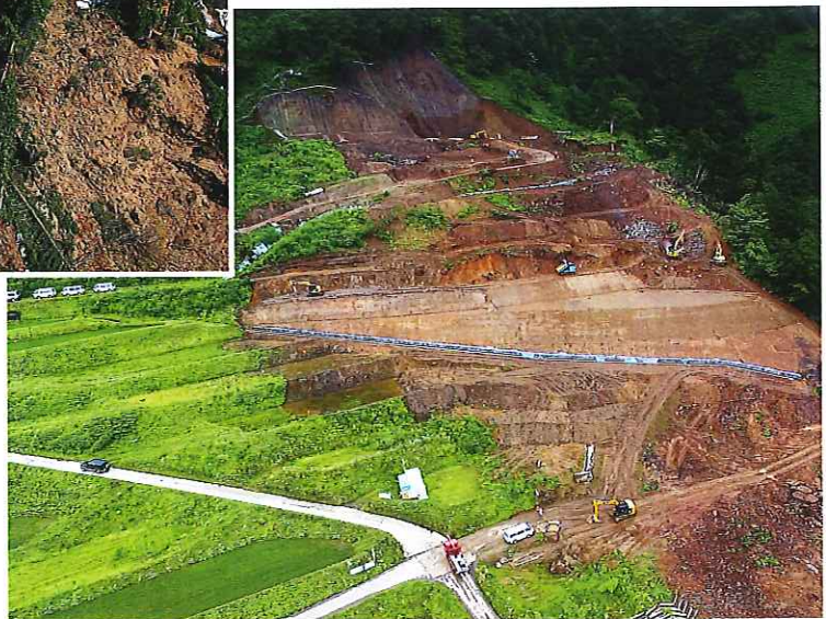
復旧作業が進む地すべり現場 (H28年 6 月28日撮影)
