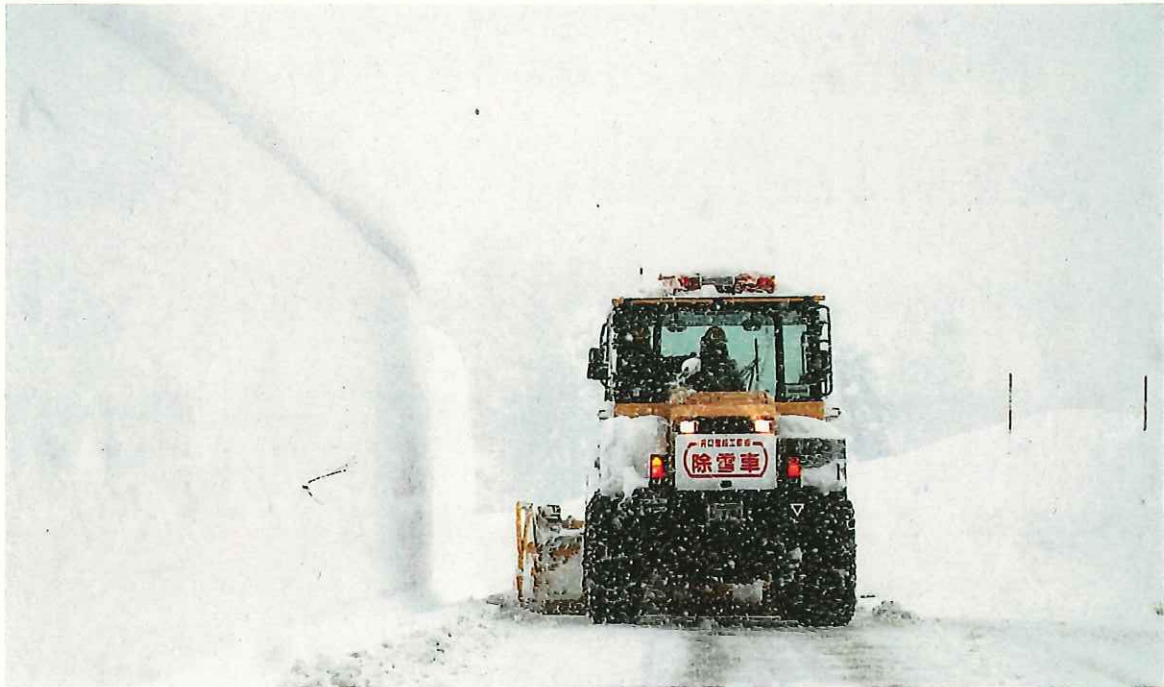
道路除雪作業
