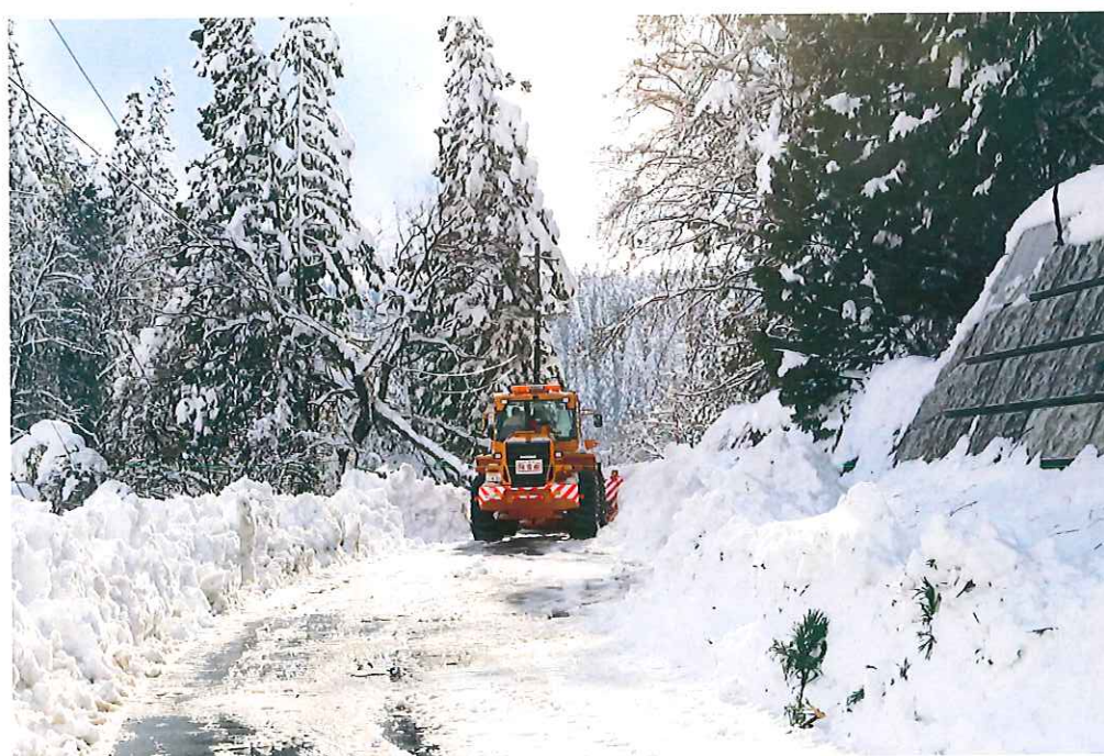
道路除雪作業
